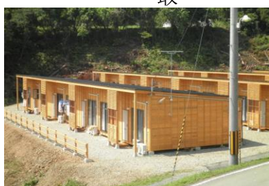
取組の先駆けとなった歌津地区木造仮設住宅
