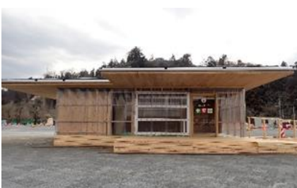
ユニット開発で生まれたCLT案内所
