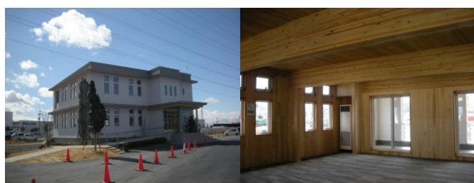
H29 ナイス株式会社仙台物流センター (CLT+RC 平面混構造)
